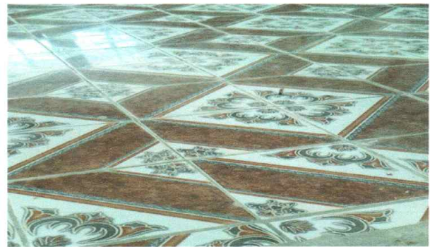
Foto 4: sustitución de piso 34 m2
