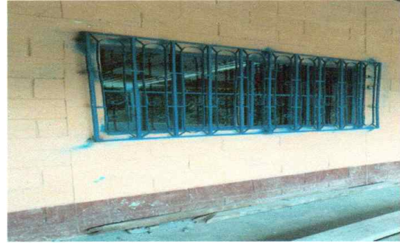
Foto 2: Sustitución de ventanas mide 1X1 m2
