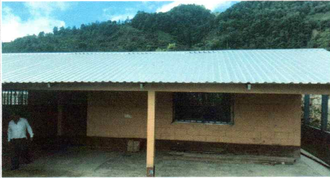
Foto1: Sustitucion de techo
