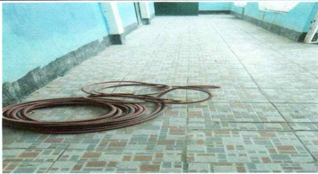
Reparación de piso 22 m2
